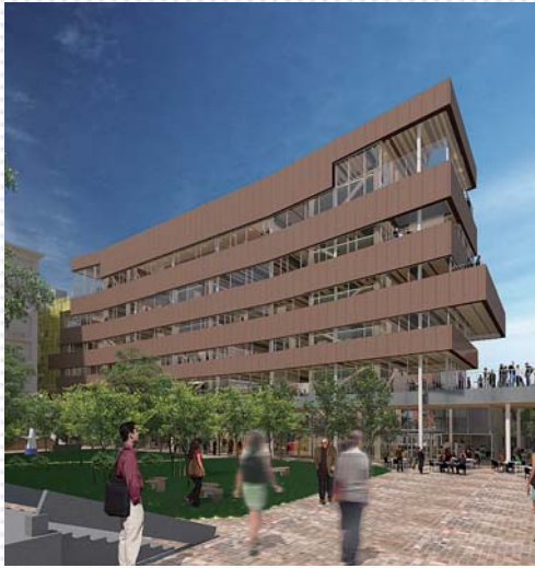
学園創立70周年の記念事業として建設中の新4号館。外国語自律学習支援室(NINJA)、ラーニングcommons、カフェラウンジなどの施設を備え、新しい国際交流および総合的な学修の重要拠点と位置づけられる(2017年春竣工予定)。
