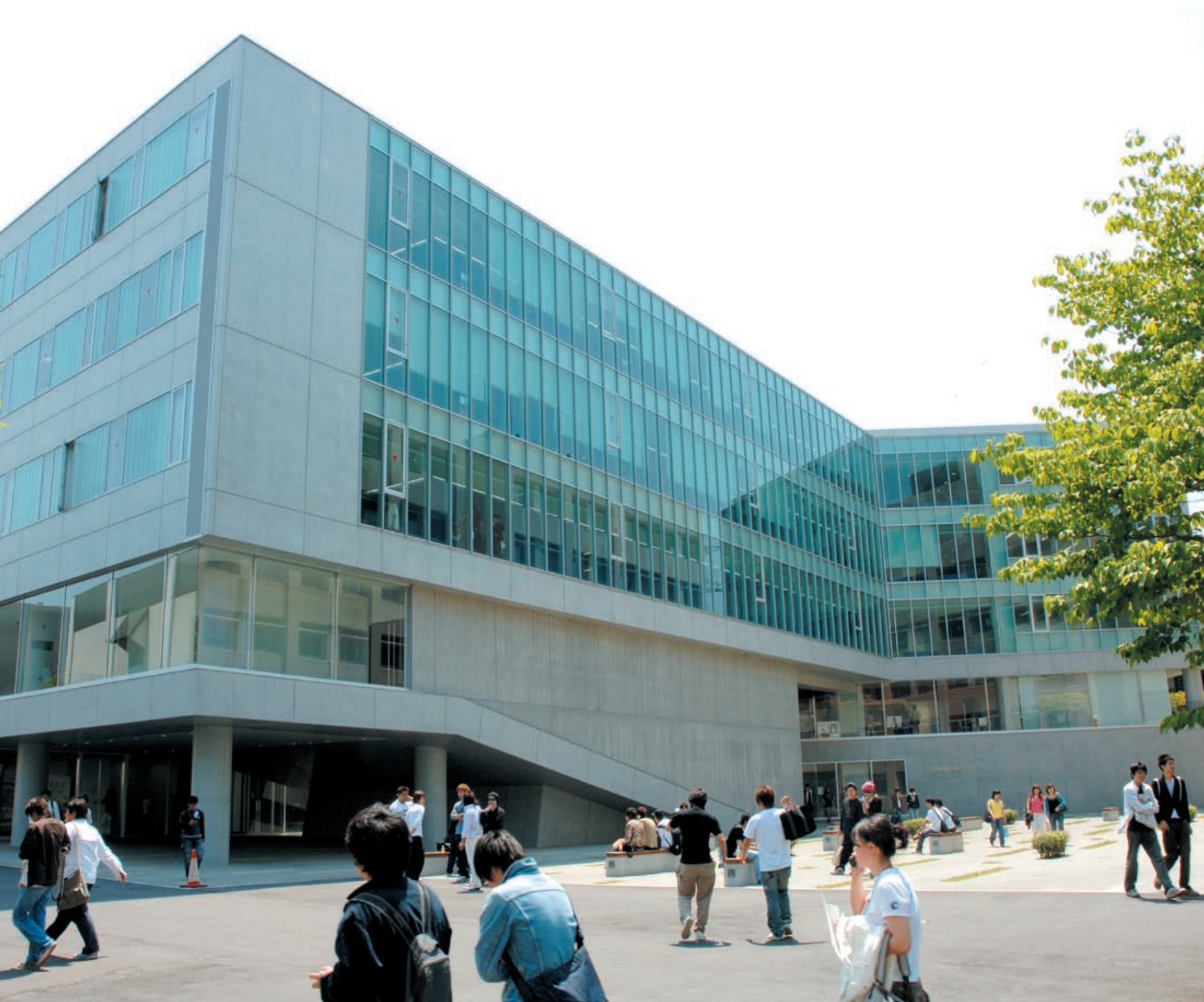
コンクリート打放しとガラスカーテンウォールの人工的なファサード。
