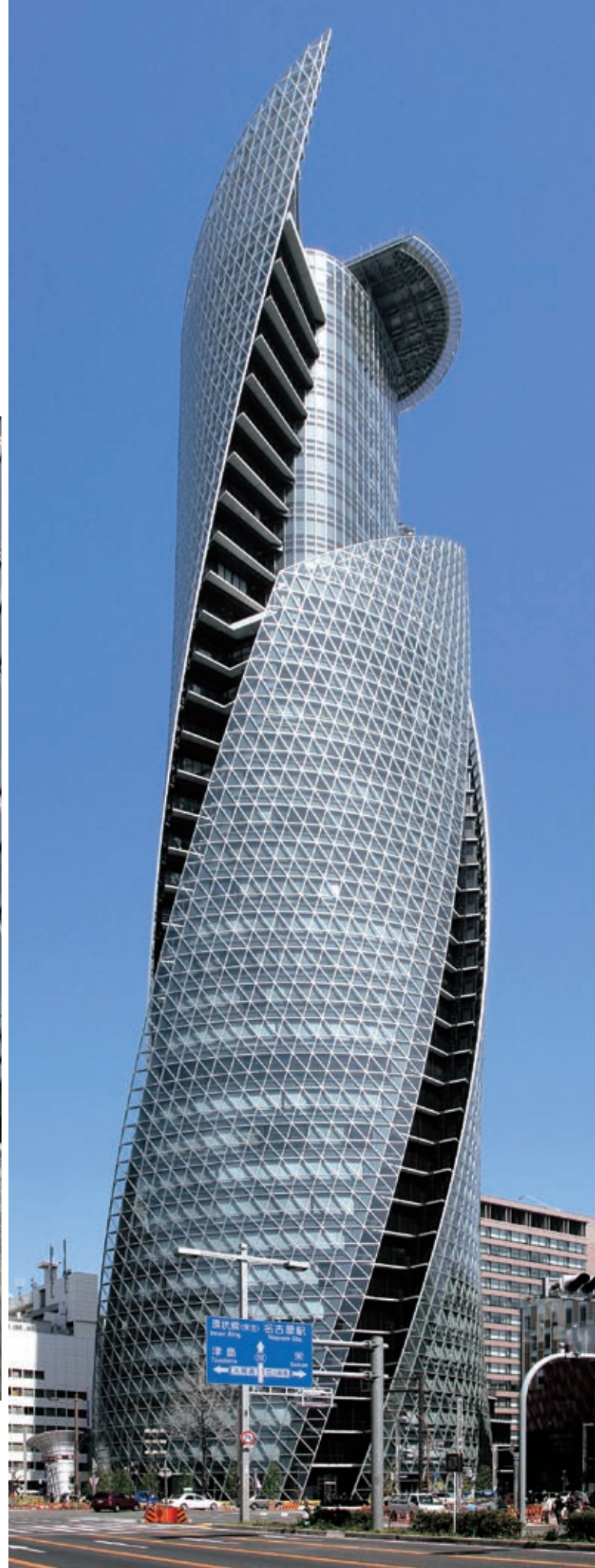
ウィングのガラスの1枚1枚が全て曲線のカーブが異なるオーダーメイド
