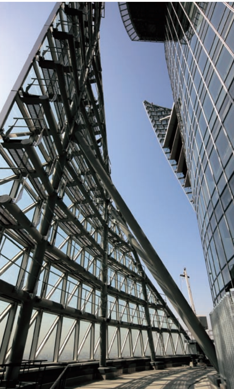
ウィングのガラスの1枚1枚が全て曲線のカーブが異なるオーダーメイド
