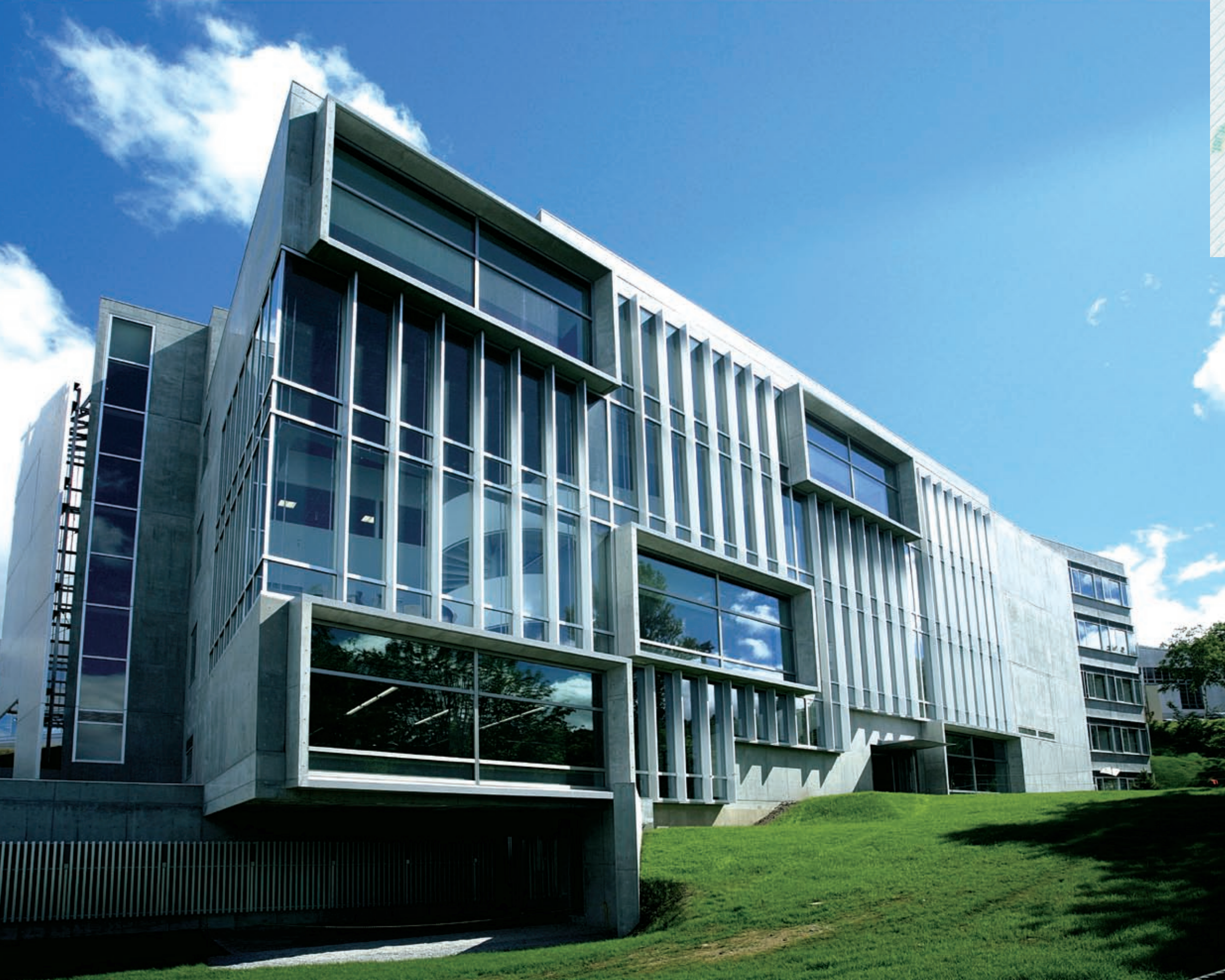
カーテンウォールと「Room」がモザイクを織り成す象徴的なファサード。
