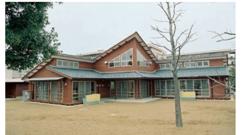
L字型の外観は、空間を広く見せつつ、連続的なつながりを出すのが狙い。(はなみずき保育園)
