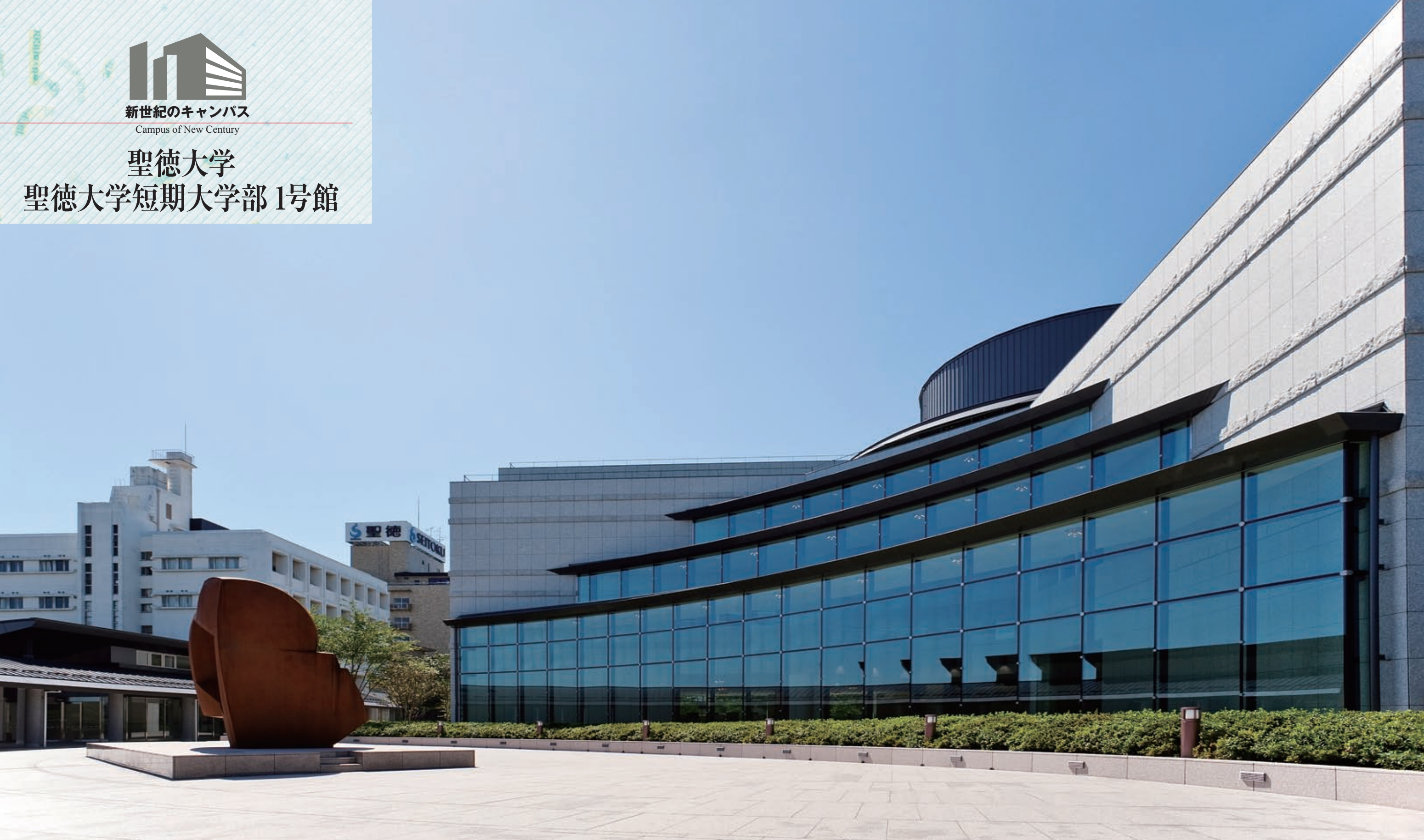
聖徳大学の新たなキャンパスコアとなる1号館は、図書館、調理実習室、ホール、メディアパークなどを備えた複合施設だ(千葉県松戸市)。
