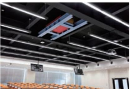
8Fの多目的講義室は天井をスケルトンにし、「床上下振動用制振装置」や構造部材を直接見せる仕掛け。
