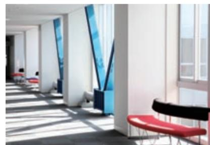
5-9Fに設置された、地震時の衝撃力を吸収し分散する制震装置「粘性ダンパー」。フロアごとに色と大きさを変え、教材として学生に見せている。
