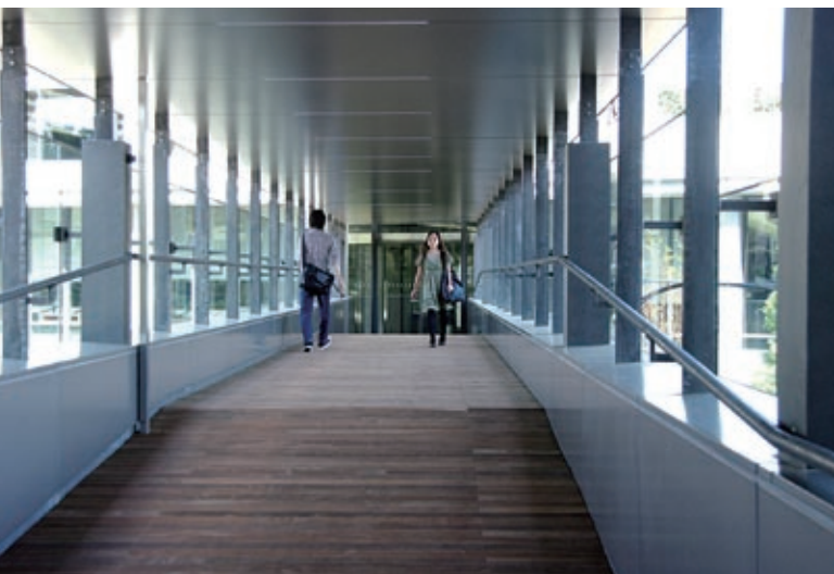
公道の上に通された、3号館と学術メディアセンターをつなぐブリッジ。
