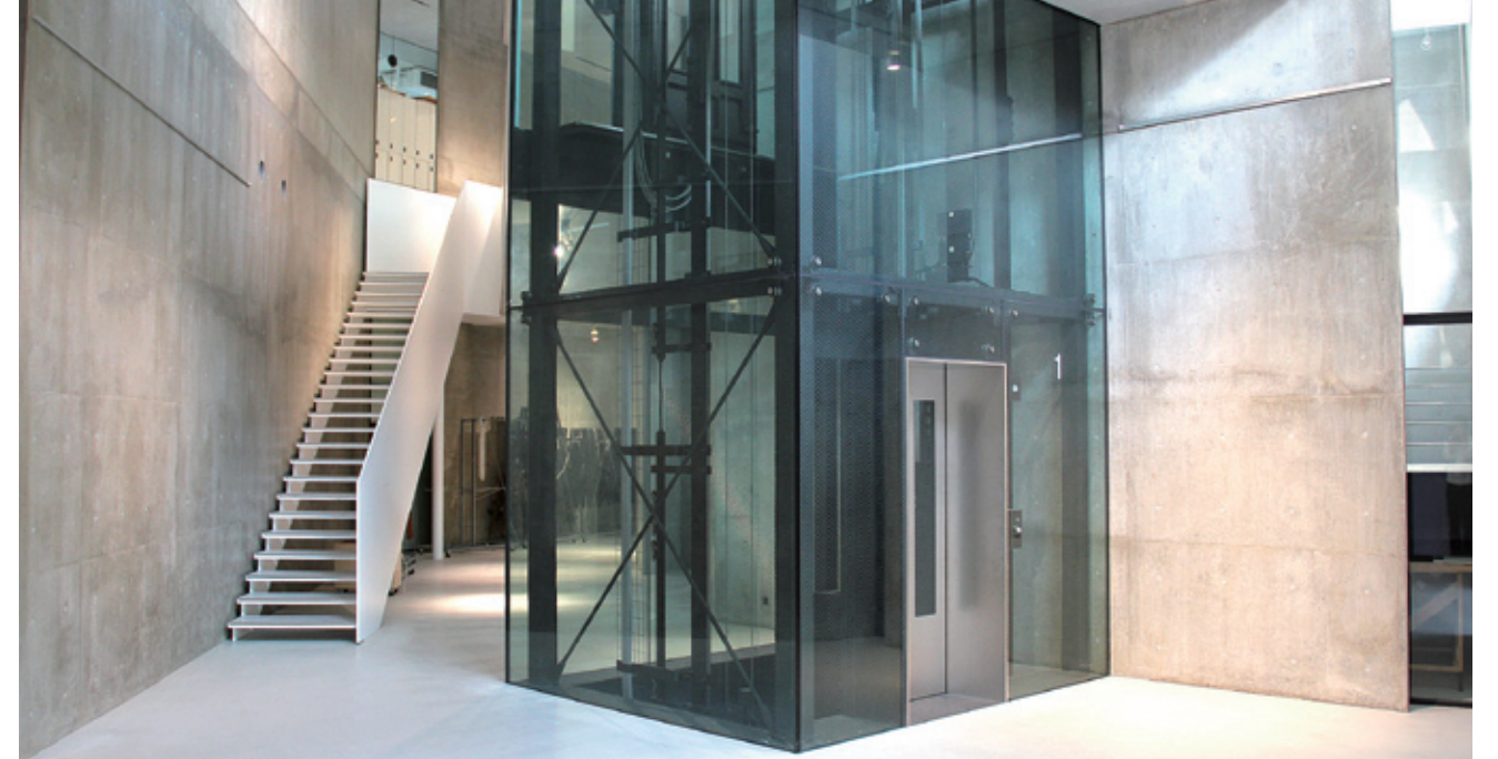
1F エントランス吹き抜け。遠近法を応用し、階段幅を下部に行くにつれ狭くすることで、平行に見える仕掛けが。
