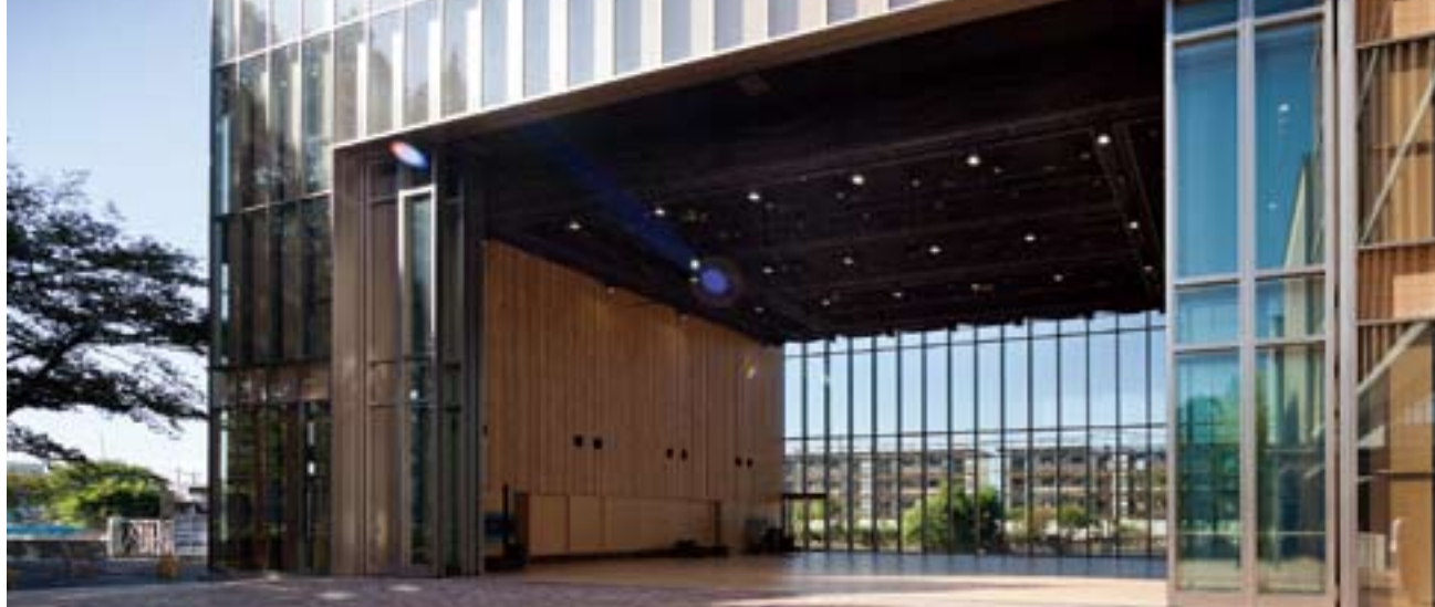
雄飛ホールには舞台を内蔵。10m高の可動ガラス扉を開放すると、オープンエリアになる。
