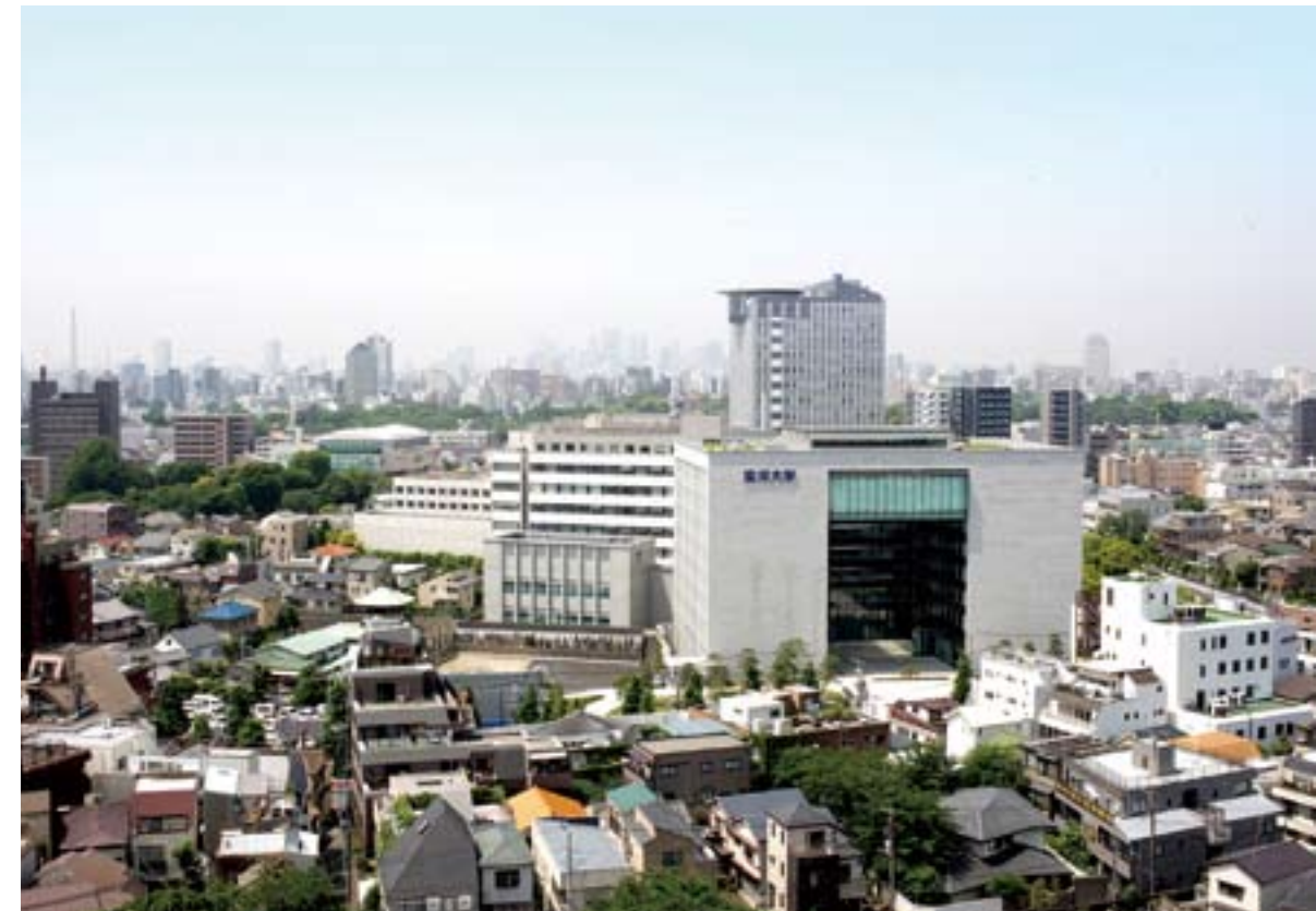
白山キャンパスの玄関口に、高さ38m、建築面積約3515㎡の巨大なランドマークが誕生した。
