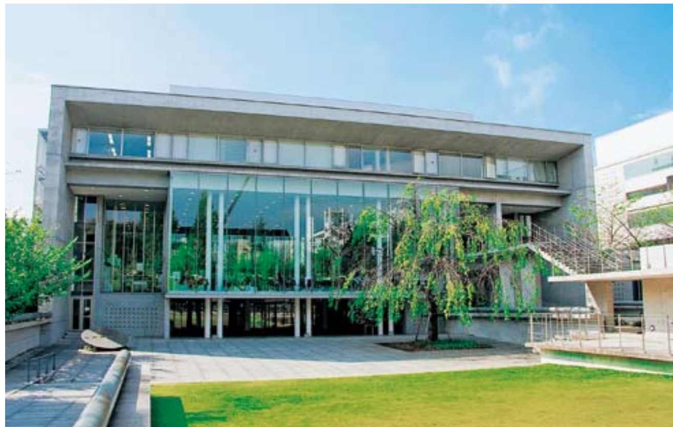
「SAKURA CENTER #14 (体育館・食堂棟)」前のサクラガーデンは、学生・教職員・地域住民が集う新たなパブリックスペースだ。
