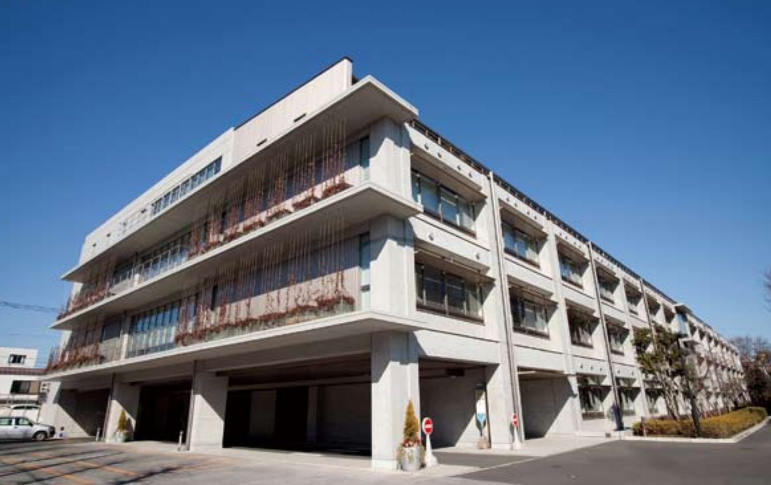
1号館の外観。全長100mを超える、世田谷キャンパスの新たなランドマークが誕生した。
