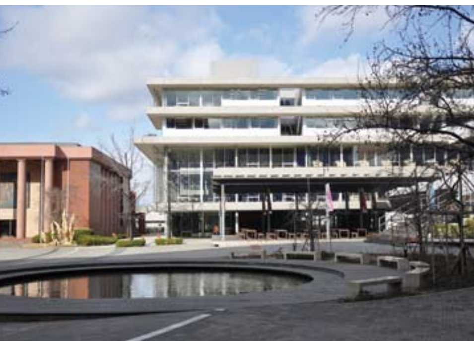
要所に赤レンガを採用することで、既存の建物と調和するデザインとしている。
