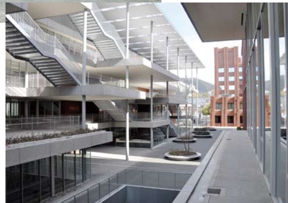
和顔館は、床とコアで構成された「スラブタイプ」の建物。可能な限りコンクリートの壁を減らしてガラス壁を多く使い、 内部の様々な活動を可視化することで開放的な空間を整備している。
