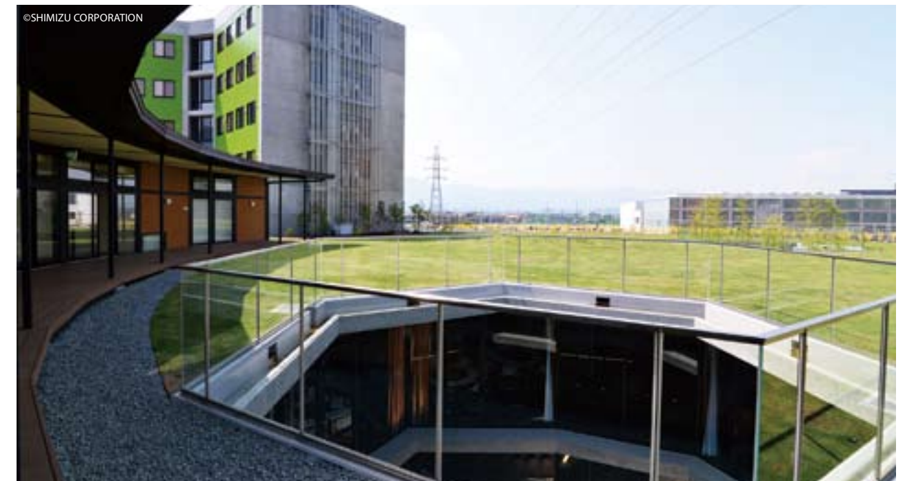
真ん中の教室棟屋上には緑化スペースも。学生や教職員の憩いの場となる。
