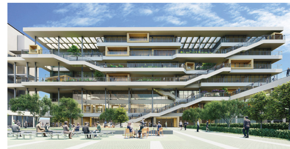
外観 ※2022年5月現在工事中
