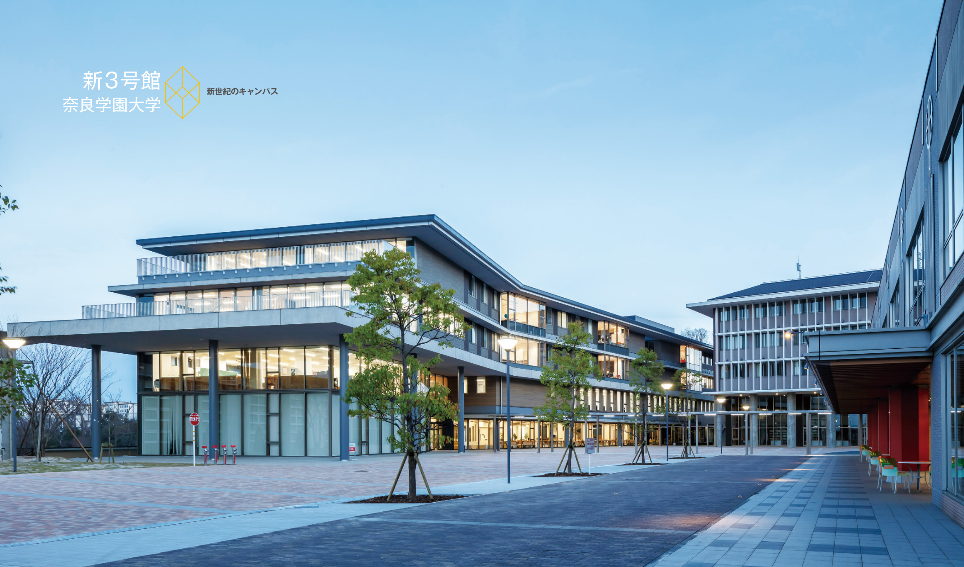
新3号館の全景と右側は時計回りに2号館及び1号館
