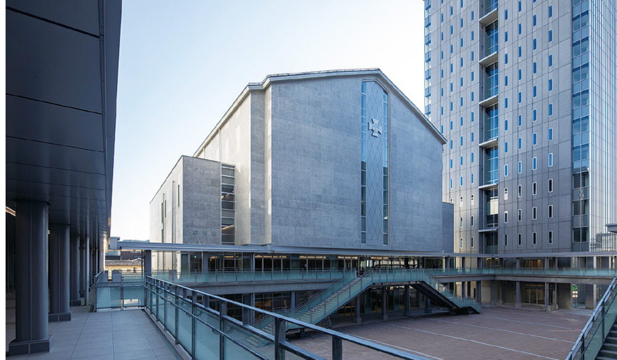
TGUリング(各棟の2階部分が回遊路で結ばれている)
