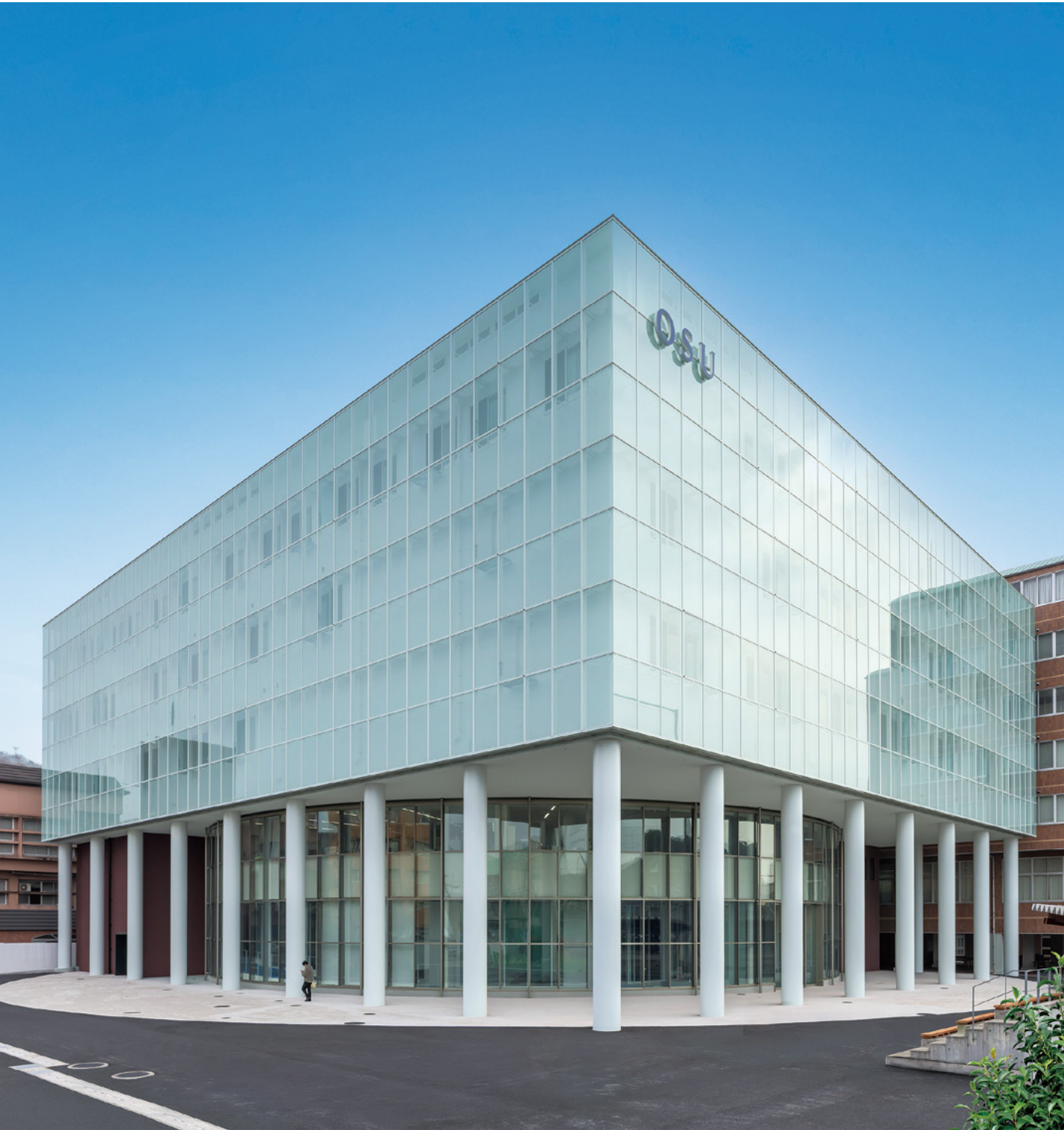
11号館外観。SDGsへの対応から3~5階はダブルスキンファサード（二重外皮構造）となっている。
