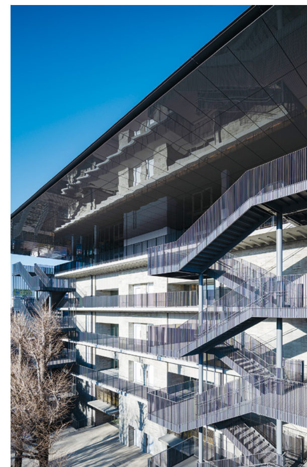
本部棟屋外階段は幅1.9m。学生がゆとりを持って行き交い、視線が交差する開放的な動線を実現。
