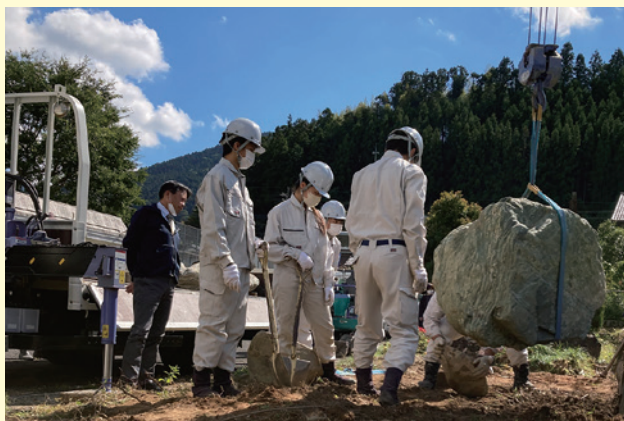
環境デザインコース3年で行われた庭園施工実習のひとつ。地元の造園業者の協力の下、クレーンを使って巨大な庭石を正門前の庭に配置している。生徒の希望で実施された授業で、設計も生徒たちが行う。安全面に配慮するほか教員は口を挟まない。
